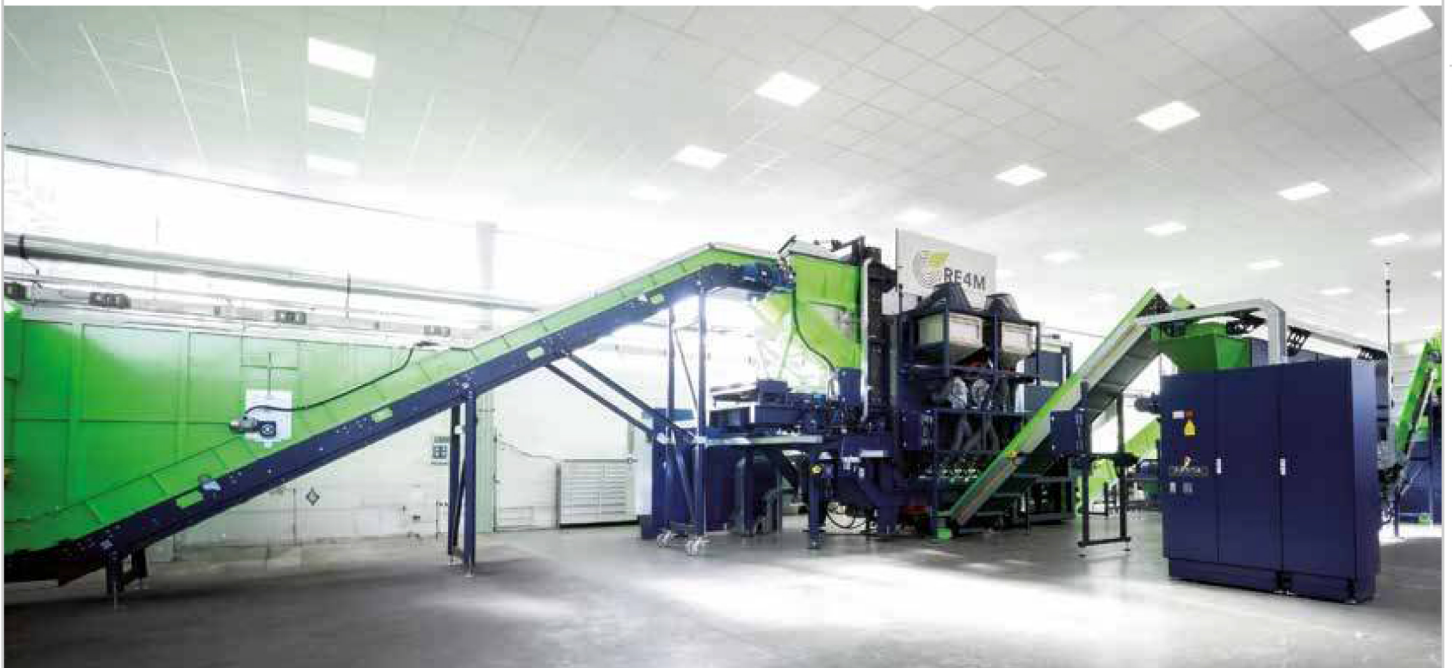
L'impianto RE4M in fase di completamento nella sede di Osai GreenTech a Torino. Quando sarà completato verrà installato nel polo per l'economia circolare del Gruppo Iren a Terranuova Bracciolini (Arezzo). The RE4M plant under completion at Osai GreenTech in Turin. Once complete, it will be installed in the circular economy district of Iren Group in Terranuova Bracciolini (Arezzo).
